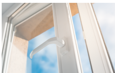
窓や扉の開閉
